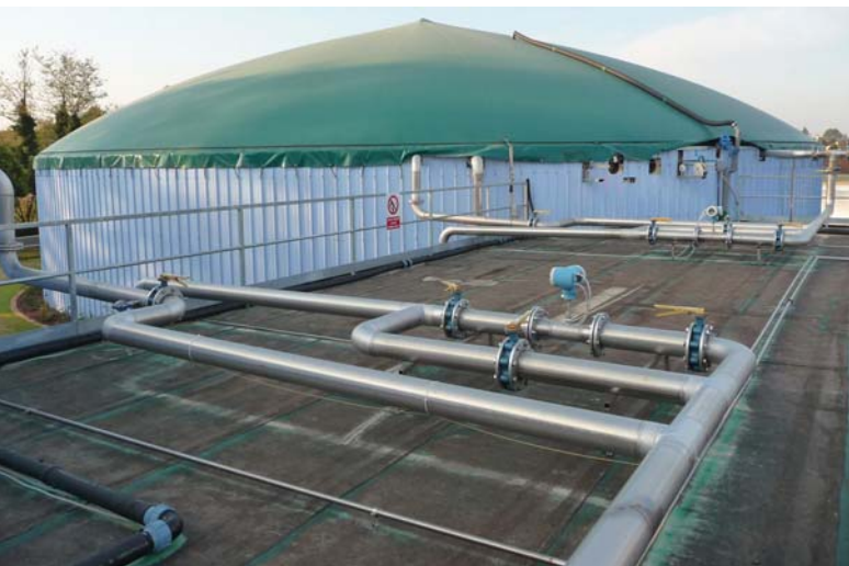
▲ SEKO prevede un generoso dimensionamento dei digestori dove proliferano i batteri, con più elevate produttività di gas, immagazzinato in cupole gasometriche che presentano una maggiore capacità di stoccaggio
