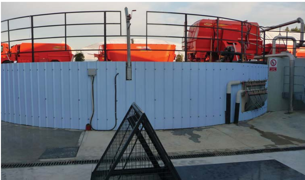
▲ Ecco la prevasca chiusa di cemento, agitata e termostata, nella quale avviene la imbibizione delle matrici organiche con il liquido digestato di ricircolo o acqua di rete
